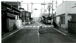
アスファルト廃材の再利用
