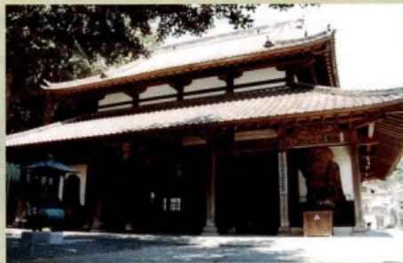
日本の黄梁様建築とは、伝統的様式に習熟した日本の大工棟梁が、長崎の中国明代の黄梁様式を、直接・間接に解釈して万福寺に建立した様式で、当地蔵堂の場合、柱上の舟肘木・出梁構造に特徴があり、堂宇周囲に裳階が付き、入口土間床、太鼓形礎盤、火灯窓など、諸々に黄梁様式が見られる。
