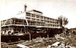
市立病院第1期工事 (昭和33年)
