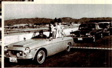
西海バイパスの 開通(昭和47年)
