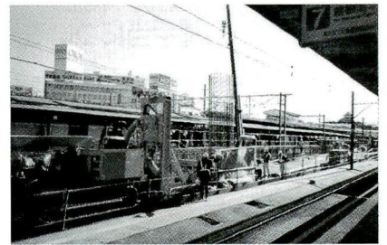
本体部分(東海道線と小田急線の間)の杭の施工
