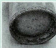
溶接部とその周辺の腐食
