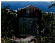
柏山頭首工の完成の碑
