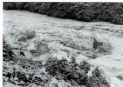
御殿場線六軒屋鉄橋
