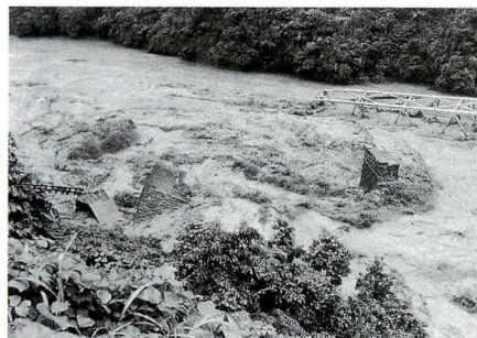
御殿場線六軒屋鉄橋
