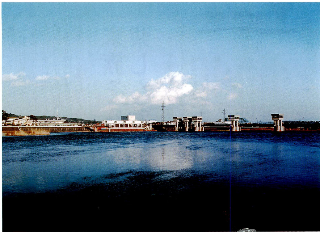
飯泉取水堰(いづみしゅいせき) 酒匂川河口から2.3km上流に設置された長さ342.5mの全面稼働堰。左岸の取水口から1日最大180万9千tの源水を取水し、ポンプで揚水して送水しています。
