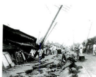
地割れを起こした道路 山角町付近(南町)
