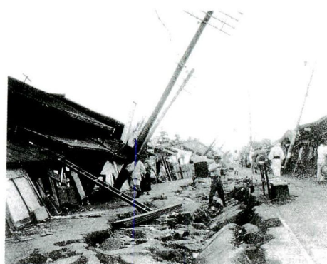
地割れを起こした道路 山角町付近（南町）
