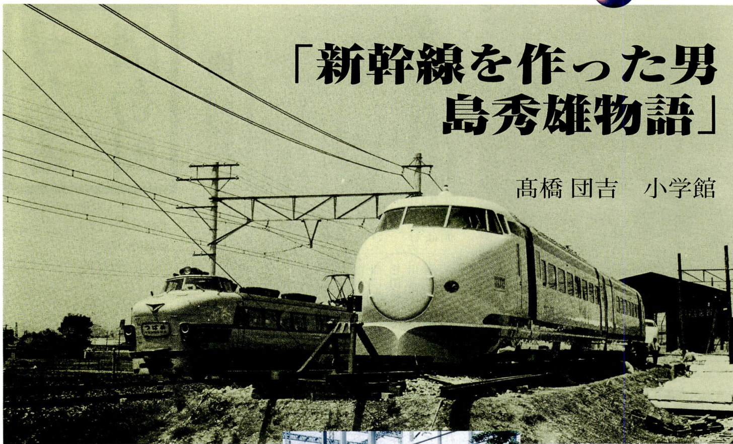
鴨宮基地で試運転が開始された。新幹線の向こう側を「特急つばめ」が通過していく(昭和37年)
