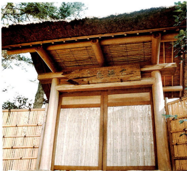
茅葺切妻四脚門 山縣有朋の筆による古稀庵の額が掛かる。
