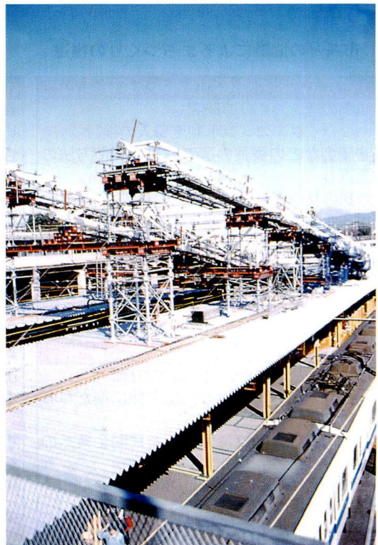
圏域を越えた交流圏の玄関口として期待がかかる、小田 原駅東西自由連絡通路。平成15年度末の完成を目指して、 急ピッチで作業が進んでいる。
