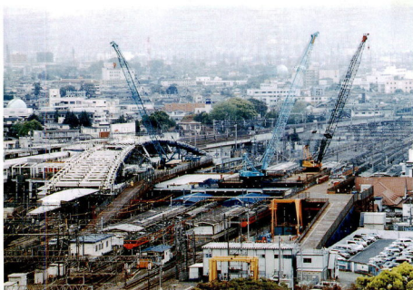
自由通路本体工事の進む小田原駅
