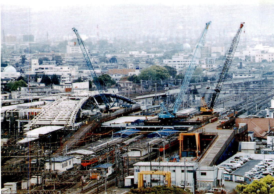
自由通路本体工事の進む小田原駅
