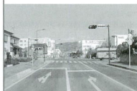
電線類地中化工事が完了した都市計画道路酒匂管線
