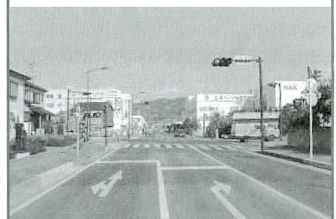
電線類地中化工事が完了した都市計画道路酒匂曾我線
