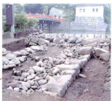
馬出門の北側の石垣。1段目から2段目にかけてが残されています。内側には裏込めに栗石と呼ばれる川原石が詰め込まれています。
