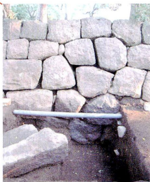
今まで残されていた南側の石垣も根元や後側を調査。2段分が埋もれていました。当時の地面はもう少し深かったようです。
