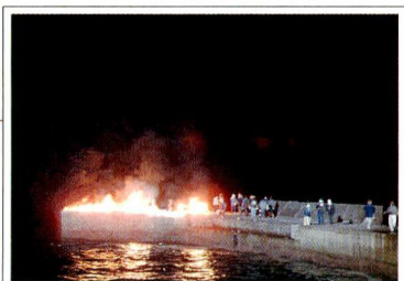
市漁協の協力により米神漁港で行った爆破シーン
