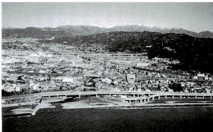
国府津―松田断層付近
