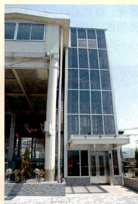
駅エレベーター
