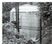
市校所敷地内に設置されている震度計。ここでのデータをもとに「小田原市被害」の震度計が気象庁から発表されます。
