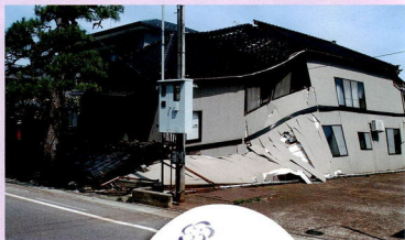
新潟県中越沖地震で被災した建物やブロック塀(上写真)。家屋では、かわら屋根で上部が重く、筋交いが少ない建物が壊れる例が多かったようです(右写真)。古い建物や塀は点検をしましょう。
