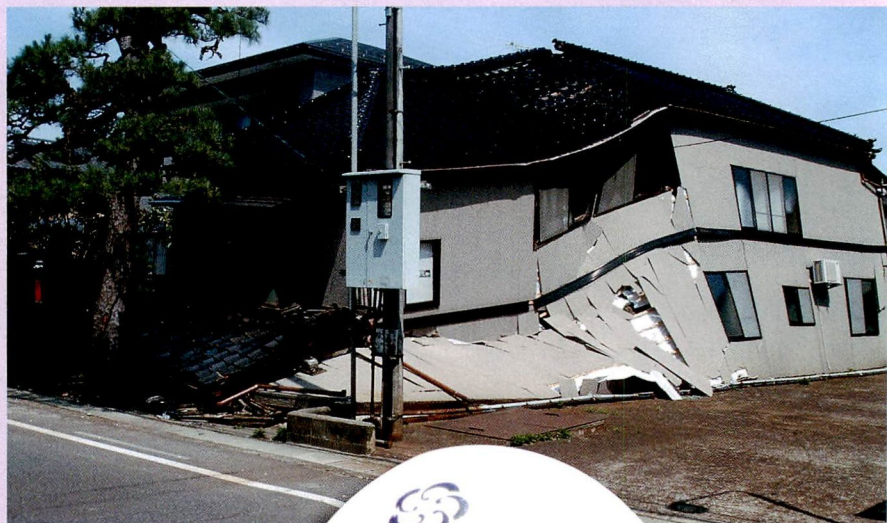
新潟県中越沖地震で被災した建物やブロック塀(上写真)。家屋では、かわら屋根で上部が重く、筋交いが少ない建物が壊れる例が多かったようです(右写真)。古い建物や塀は点検をしましょう。
