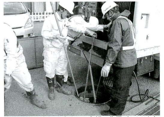
下水道管の詰まりを直すには多額の費用がかかります。
