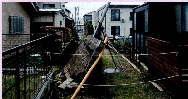
新潟県中越沖地震で被災した建物やブロック塀(上写真)。家屋では、かわら屋根で上部が重く、筋交いが少ない建物が壊れる例が多かったようです(右写真)。古い建物や塀は点検をしましょう。
