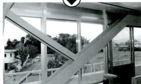
耐震補強工事で鉄柱が取り付けられた窓。外の景色は見づらくなったが、地震には格段に強くなった。
