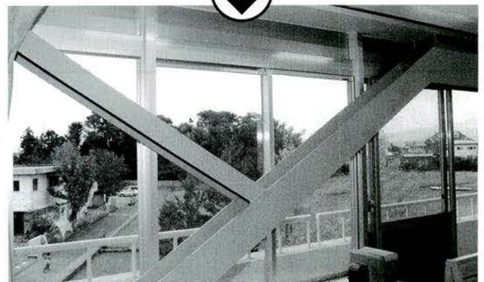
耐震補強工事で鉄柱が取り付けられた窓。外の景色は見づらくなったが、地震には格段に強くなった。
