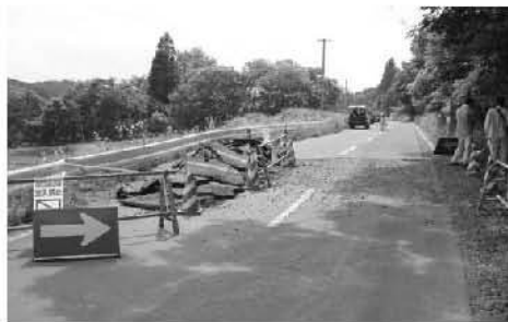
道路の破損箇所を取り除き、応急的な処置が完了
