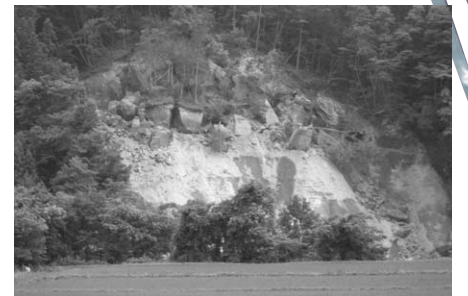
のどかな田園にも土砂崩れが迫る
