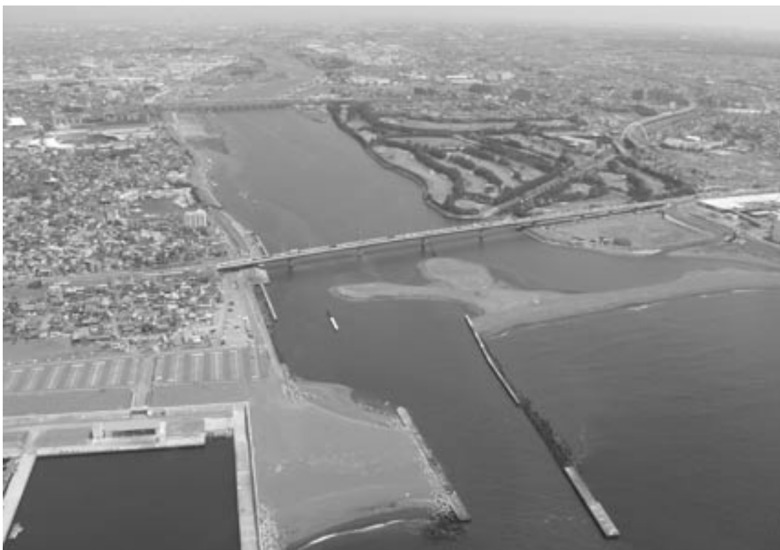
▲大きな津波は河川を遡上します(写真は相模川河口部)
