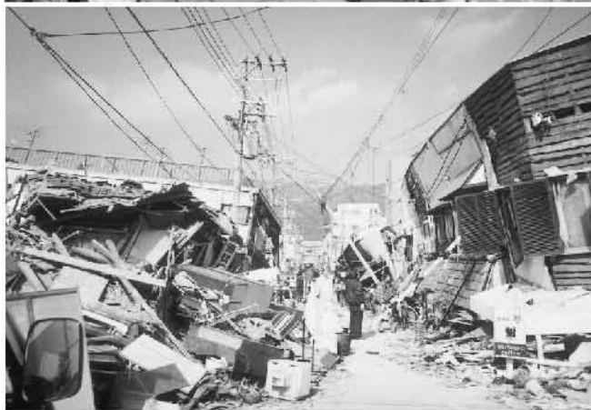
阪神・淡路大震災における木造住宅の被災状況。倒壊した住宅が、完全に道路を閉塞しています。
