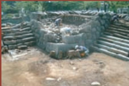
「史跡小田原城跡本丸・二の丸整備基本構想」に基づき、小田原城の整備を継続的に進めています。現在は、正規登城ルートである大手筋の整備中で、今年3月に完成した馬出門に引き続き、その西側にある馬屋曲輪全体の修景整備工事を行っています。これに先立ち、9月に南東側にある二重櫓周辺の発掘調査を行い、見学会を開きました。その後、調査の結果を基に、櫓台の石垣を本来の高さまで修復するための石積み工事が行われています。
