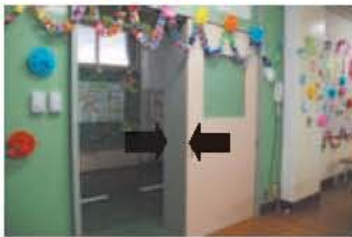
補強後...壁の厚さは約20cmです。 地震に強い建物になりました。
