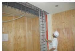
補強工事中...等間隔に鉄筋を入れて 壁を強化します。
