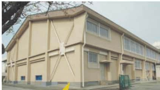
ブレース(筋交い)を入れて 建物を強化しました。 (泉中学校)
