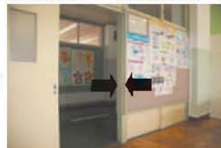
補強前...壁が薄いことが分かります。
