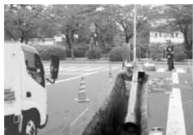
老朽管の耐震化工事
