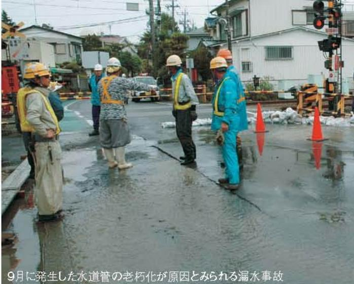
9月に発生した水道管の老朽化が原因とみられる漏水事故
