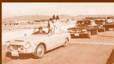
▲西湘バイパスの開通 (1972年)
