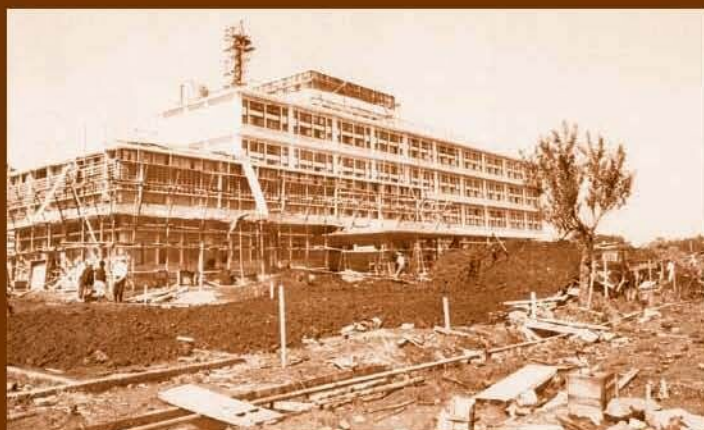
▲市立病院第1期工事 (1958年)
