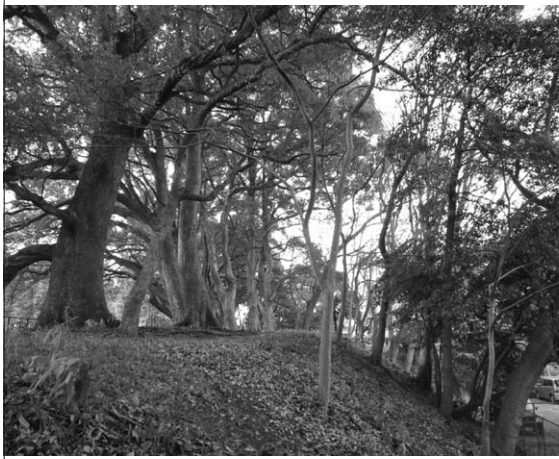
▲御用米曲輪北側土塁の樹木
