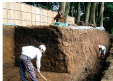
北東土塁の観覧席解体後の現状とくすのきの二段根
