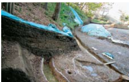
本丸側法面の現状と発掘調査の状況 法面のすそに溝が見つかりました
