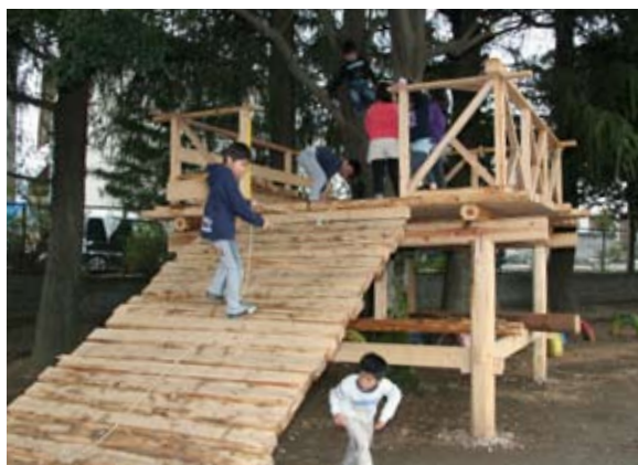
完成したツリーデッキ
