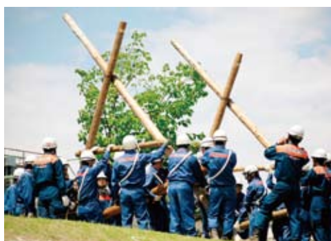
丸太を組み立て、川に入れる「四ツ杵工法」。川の流れを変え、土手の流出を防ぐ。
