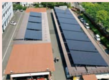
市役所車庫棟太陽光発電
