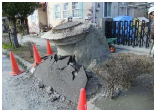
東日本大震災による被害の例
