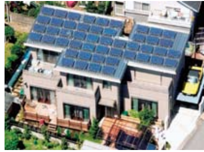
住宅用太陽光発電システム
