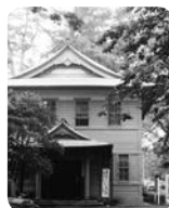
▲昭和45年頃の外観
