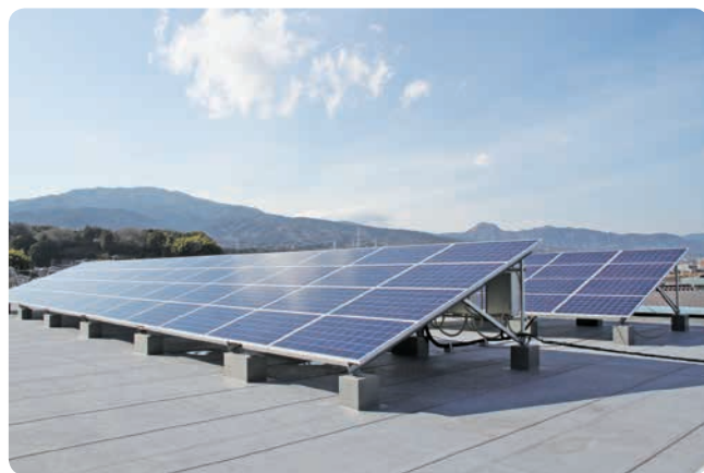
富水小学校屋外の太陽光発電設備
