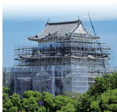
改修中の小田原城
