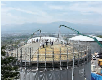
安定給水や災害対策のため整備が進む、 中河原配水池
