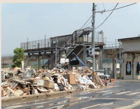
▲道路脇には、まだ災害ごみが多く残っていた
