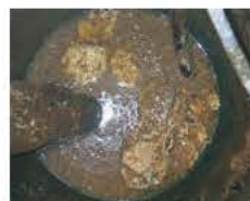
▲固まった油による下水管の詰まり
