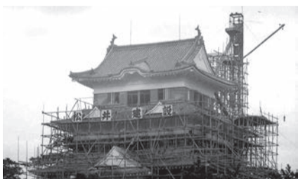
▲建設中の天守閣
