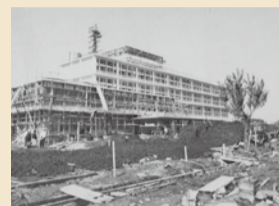
▲建設中の市立病院
