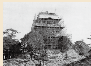
▲建設中の天守閣
