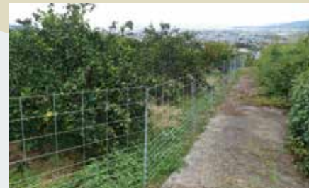
▲侵入防止のメッシュ柵
