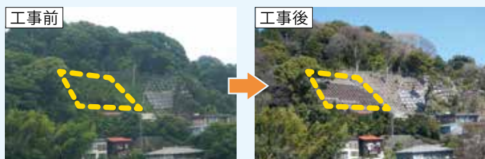
▲崩壊の危険がある急傾斜地
